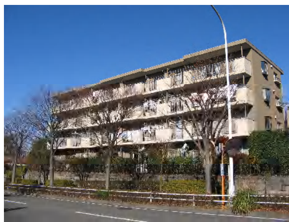
外断熱改修後
