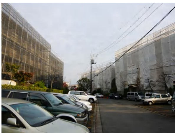
外断熱改修中
