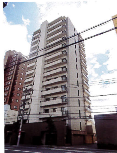
完成時北側外観
