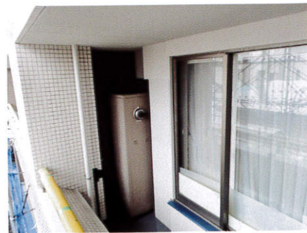
南側バルコニー内
