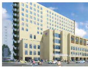
札幌市 病院・サ高住（建設中）
