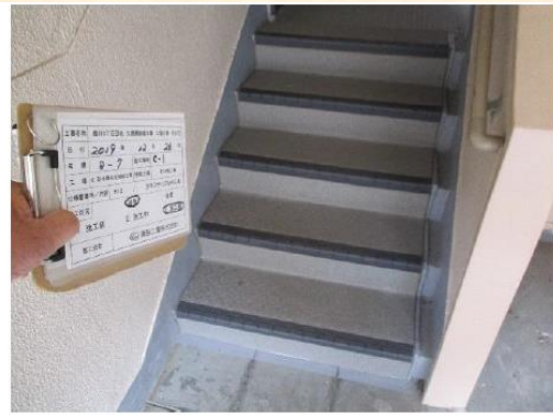
階段室 防水施工後
