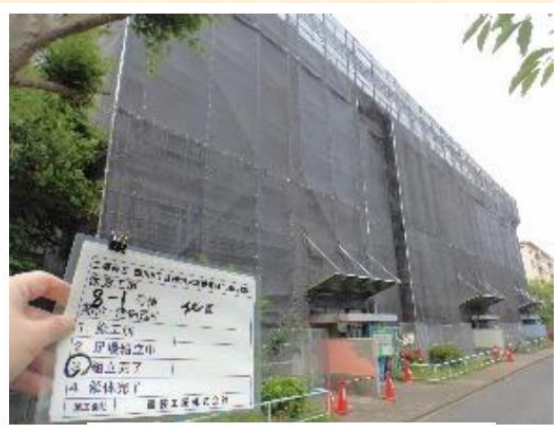
大規模修繕工事施工中
