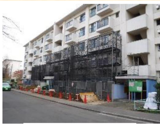
耐震補強工事施工中
