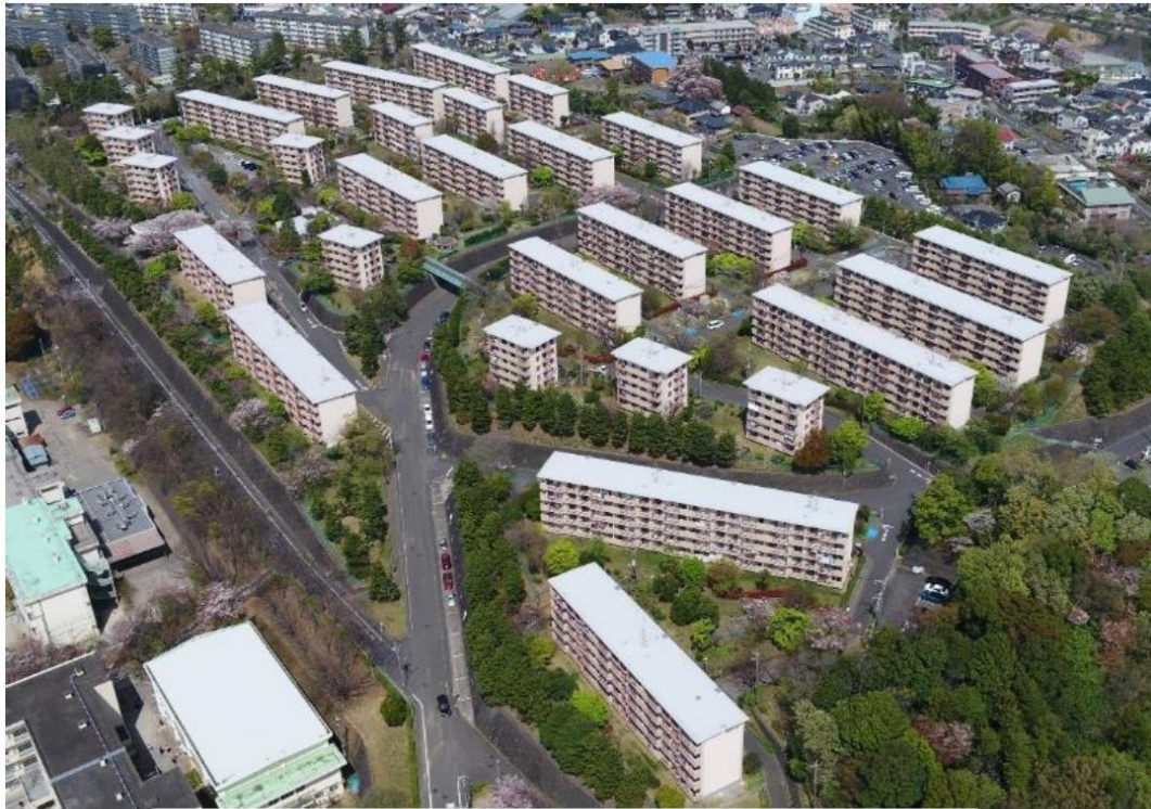
鶴川六丁目団地 竣工時（2020年4月） ドローンによる空撮
